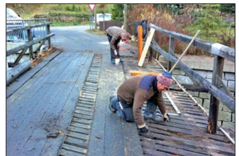
Bauarbeiten an der Brücke
