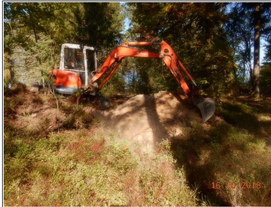
Abb: 3: Herstellung Schurf 4
