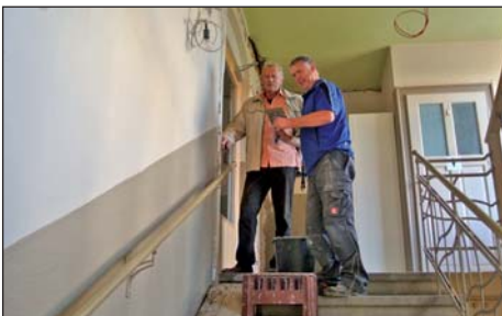
Im Treppenhaus werden die Elektroleitungen verputzt, dann folgen die Malerarbeiten
