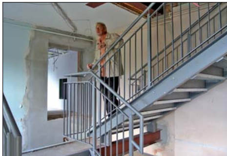
Bürgermeister Thomas Kirsten auf der neuen Treppe
