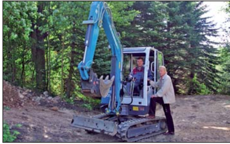
Arbeiten an der Geländeregulierung, hier entsteht der kleine Bolzplatz
