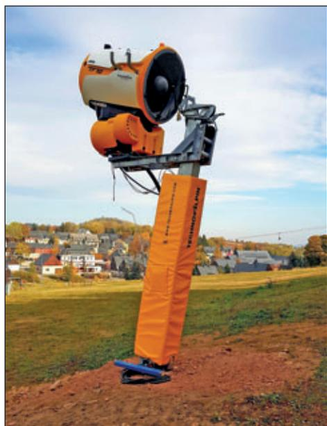
te es in den letzten Wintern immer wieder an Schnee auf dieser Strecke. Daher hat die Firma Wiegand kurzerhand eine 550 m lange Beschneiungsanlage gebaut. Auf dem 550 m langen Abschnitt der unterhalb des Restaurants „Altes Raupennest“ beginnt und oberhalb der Villa Unger endet, wurde die Schneise verbreitert und eine Hochdruckleitung für Wasser und eine Starkstromleitung verlegt. Damit konnten sechs Abnahmestellen geschaffen werden, an denen die Schneekanonen angesteckt werden können.
