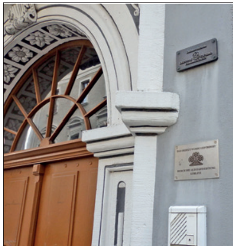
Portal (Teilansicht) eines durch die „Altstadtmillion“ (helles Schild) und Mittel der Deutschen Stiftung Denkmalschutz (dunkles Schild) sanierten Gebäudes - Foto Ingrid Blätterlein
