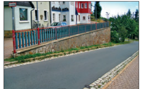
Stützmauer im Bereich Rathausstraße mit den Porphyrrplatten
