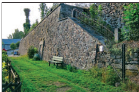
Abgang der Stützmauer von der Rathausstraße mit Bergbaudenkmal zur Oberen Straße
