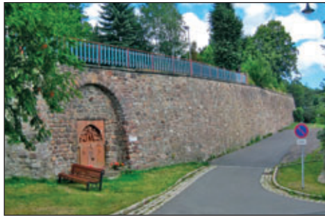
Stützmauer Obere Straße mit ehemaliger Freitreppe zur Kirche und verwahrten Stolleneingang
