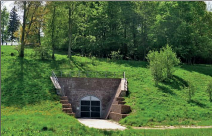
Abb. 11 Mundloch des Entwässerungsstolln im Tal der Kleinen Biela, Länge 3 925 m, Auffahrung Dez. 1991 bis Aug. 1993 im Gegenortbetrieb.
