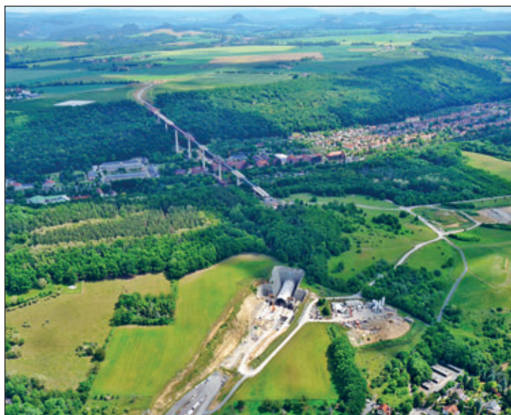
Baustelle Südumfahrung B172n Pirna Sicht aus westl. Richtung, Mai 2025, Autor: Eckhard Ehrt
