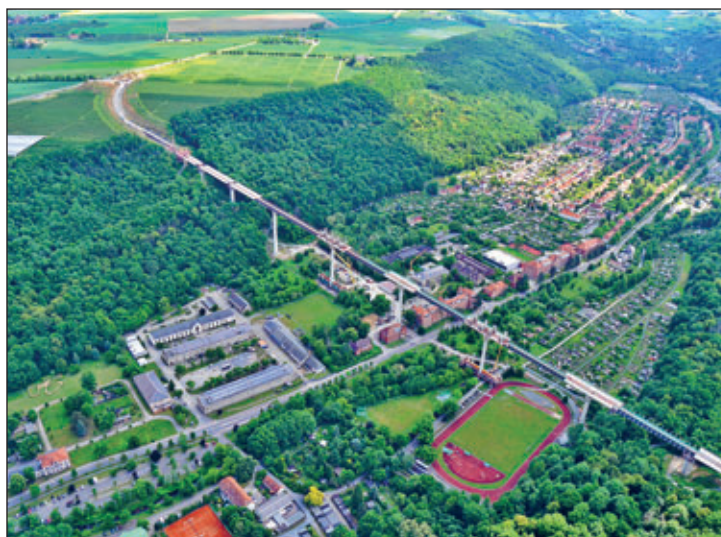
Südumfahrung 172n Pirna, Gottleubatalbrücke, Mai 2025 Autor: Eckhard Ehrt
