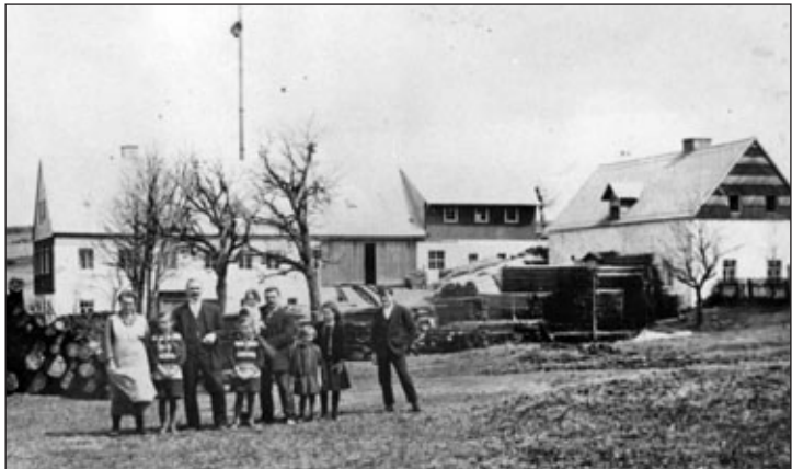
zum 50. Bestehen der Grubtmühle 1925
