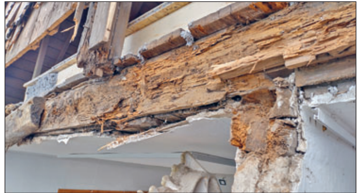
Freigelegte Reste des Deckenbalkens, links vorge nageltes Füllholz
