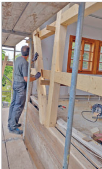
Das neue Giebfachwerk entsteht
