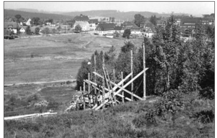
Bau der „Pionierschanze“ am Raupennesthang im Jahr 1971
