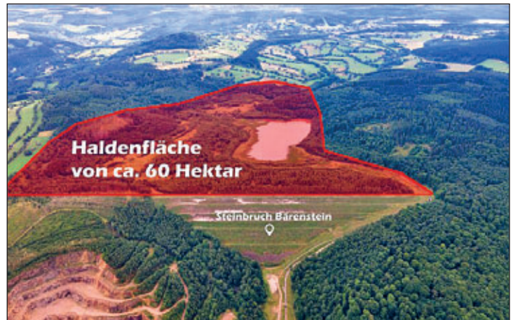
... Aufbereitungsanlage an der Bärensteiner Höhe (Fotos: BI Bärenstein).
