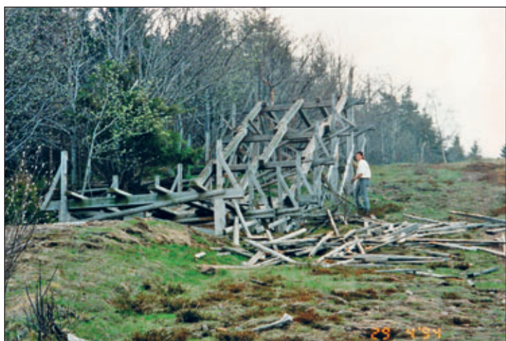
Abrissarbeiten an der Pionierschanze am 29. April 1994
