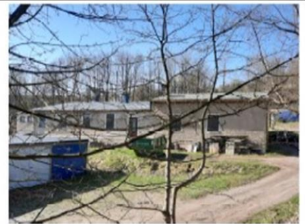
rückwärtige Ansicht des gesamten Gebäudes
