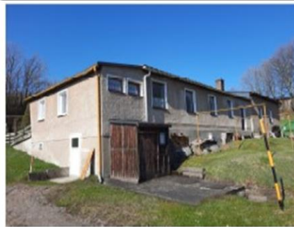
rückwärtige Ansicht des Wohnbereiches
