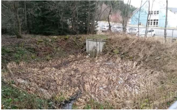
Foto 7: Regensammelbecken im Norden des Plangebietes
