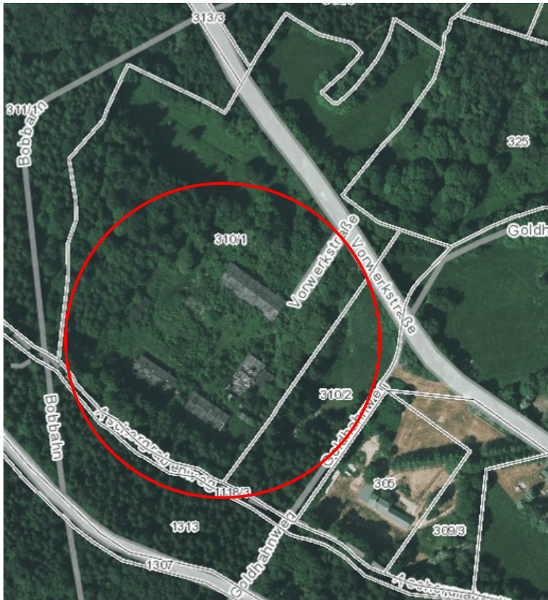
Abb. 2: Luftbild ehemaliges Ferienlager am Vorwerk (Flst. 310/1, Gemarkung Geising)
